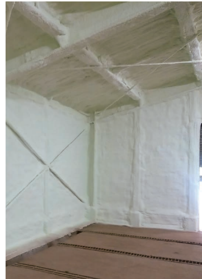
農業倉庫 壁・天井面吹付け
