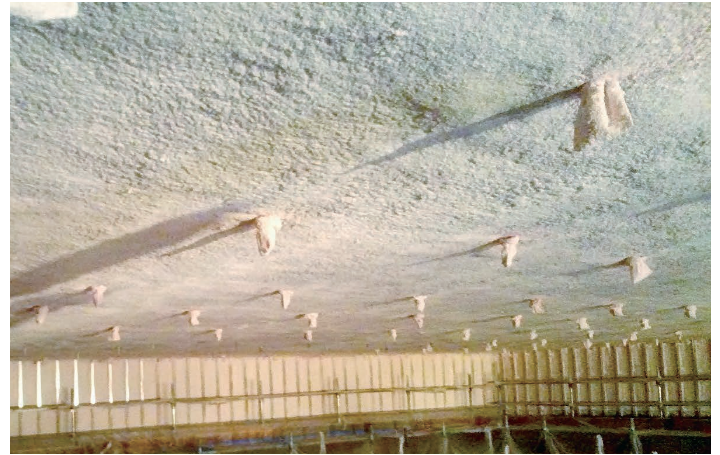
定温倉庫 天井面吹付け
